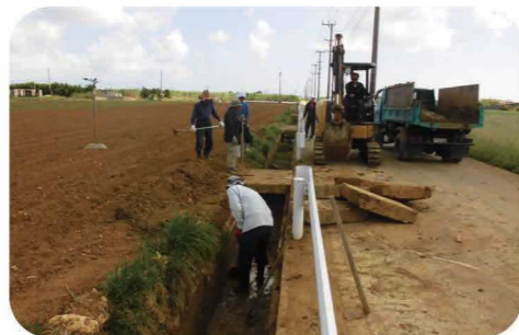
排水路の泥上げ
