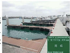
改良後(浮棧橋)
