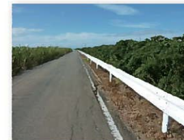
水利用調整・高効率化支援事業による改修後の法面保護
