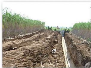
管路の布設作業
