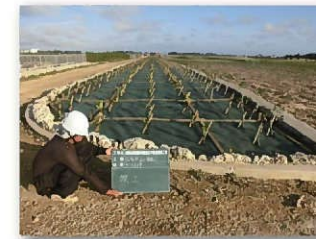
農地保全整備事業（防風施設施行後）
