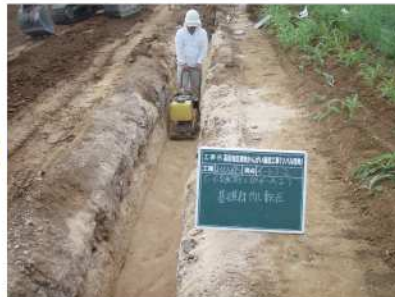
②管基礎材均し転圧
