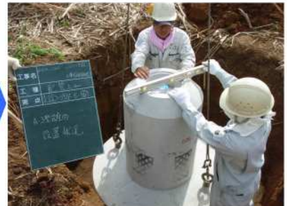
③台座設置
