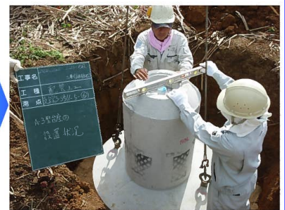
③台座設置
