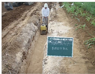
②管基礎材均し転圧
