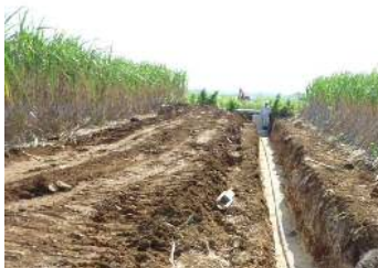
管路の布設作業
