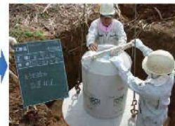
③台座設置
