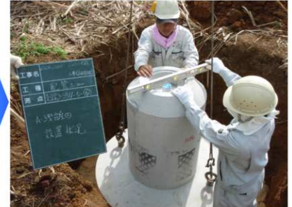
③台座設置
