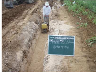
②管基礎材均し転圧
