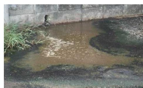
堆肥舎壁の破損による汚水の流出
