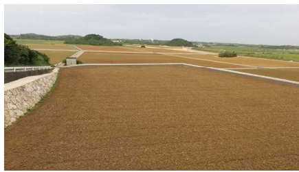
11月末工事完了 (面積40a)
