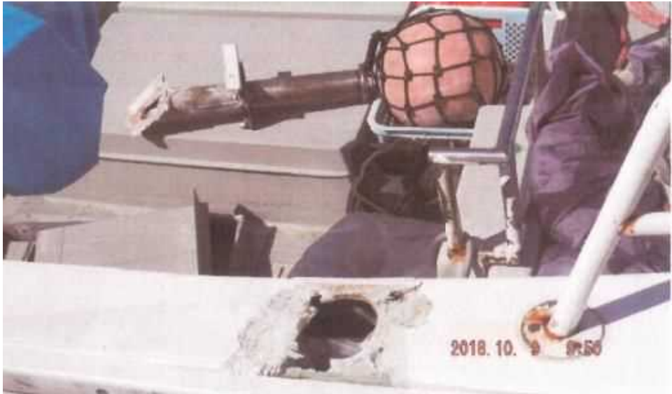
台風による漁船被害状況（右舷ビット破損）（平成30年10月撮影）
