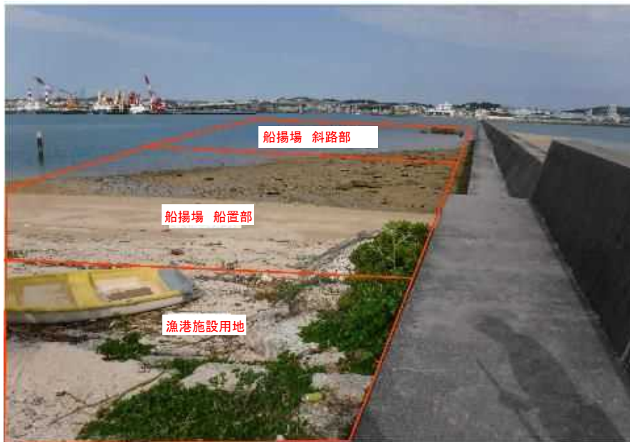
大型漁船用船揚場の新設箇所状況（糸満漁港北地区）（令和2年4月撮影）
