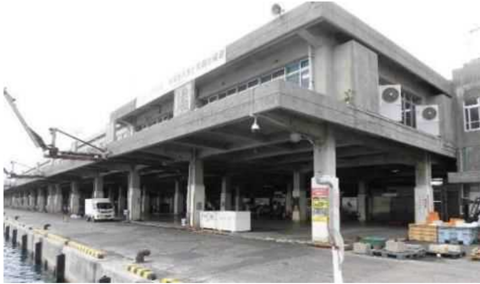
荷さばき施設全景（泊漁港）（平成31年1月撮影）
