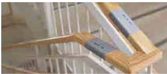
リュウキュウマツの手すり
