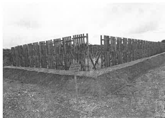
写真-2 盛土および防風工
