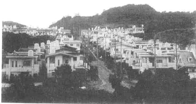
写真-1 貯水タンクの設置状況
