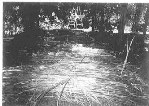
写真-2 植込み完了図（同上）
