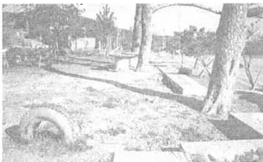
写真-14 コーラル敷き固め状況
