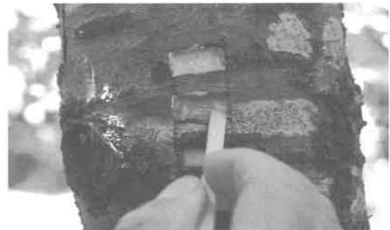
写真－1 付傷および塗布の状況
