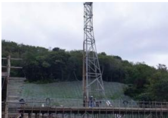
復旧治山（中城村奥間）
