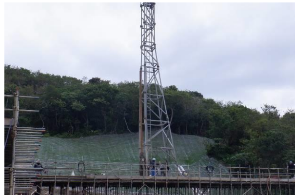
復旧治山（中城村奥間）
