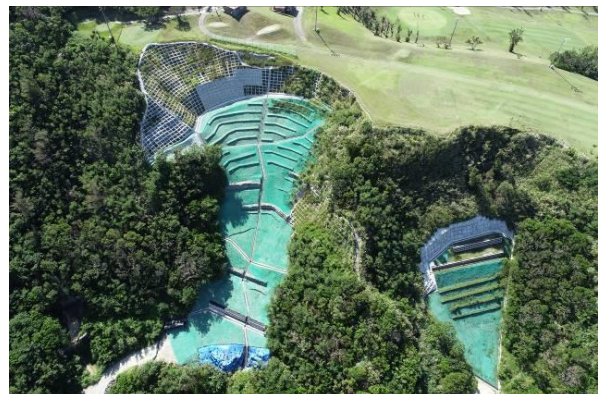
林地荒廃防止施設災害復旧（南城市安座真）
