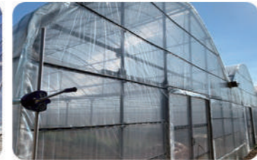
ハウスを密閉して蒸し込み処理
