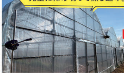
栽培終了後は圃場(施設)蒸し込み ※高温による配管パイプの曲がり等にご注意
