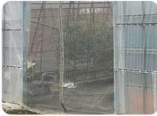
二重カーテンで出入口からの侵入を防ぐ
