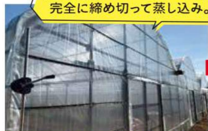
栽培終了後は圃場(施設)蒸し込み ※高温による配管パイプの曲がり等にご注意
