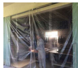
集荷場入口のネット設置
