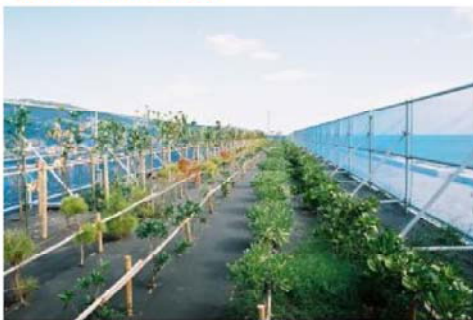
整備直後の状況
