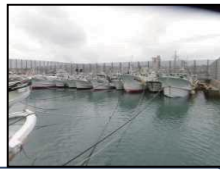
防風柵整備による安全係留
