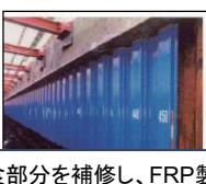
腐食部分を補修し、FRP製カバーによる腐食防止対策
