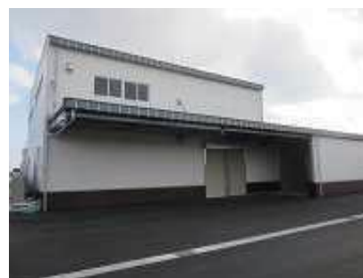
農産物集出荷貯蔵施設（マンゴー・トマト）
