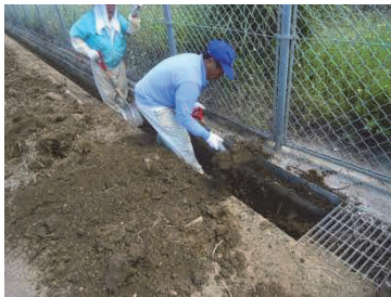
排水路の土砂上げ
