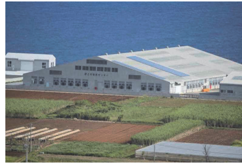
農村集落基盤・再編整備事業 (地域資源活用施設整備)
