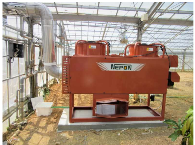
栽培施設内環境制御装置(加温機等) (平成30年度園芸産地機械整備事業)
