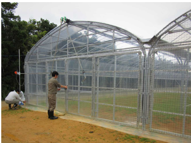
気象災害対応施設(強化型パイプハウス) (平成30年度災害に強い強化型施設整備の導入推進事業)
