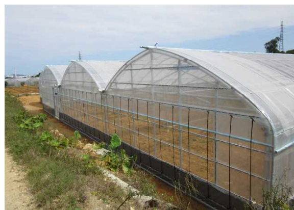
強化型耐候性施設(強化型パイプハウス) (令和2年度災害に強い高機能型栽培施設の導入推進事業)
