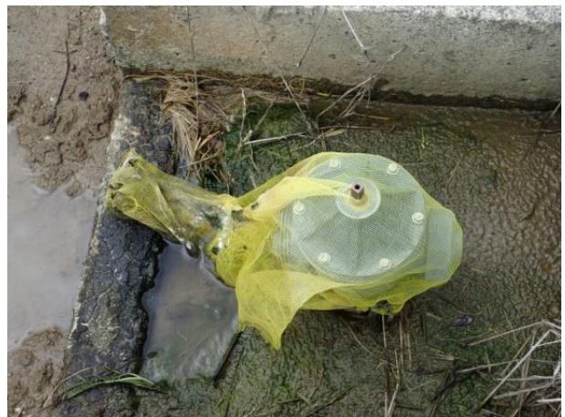
図6 取水口の侵入防止網
