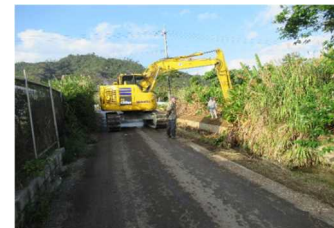
▼排水路の土砂撤去（喜如嘉）
