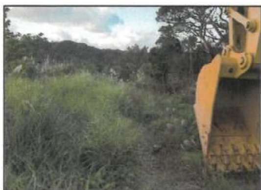
農道伐採状況
