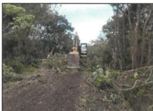
農道伐採状況
