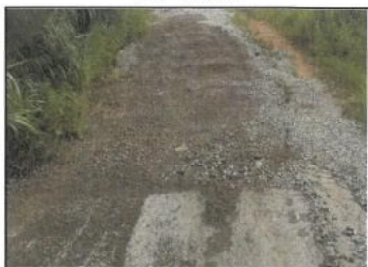
農道の整備後
