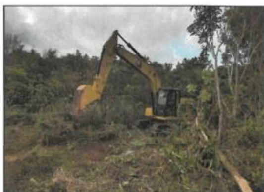
農道伐採状況
