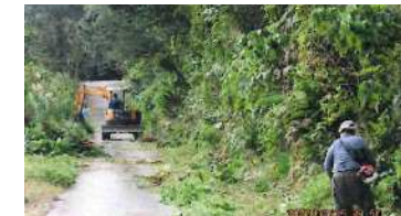
▲農道の草刈り作業（安部）
