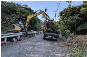
▲農道伐採作業（崎本部）
