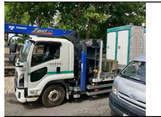
(仮設トイレ設置)
