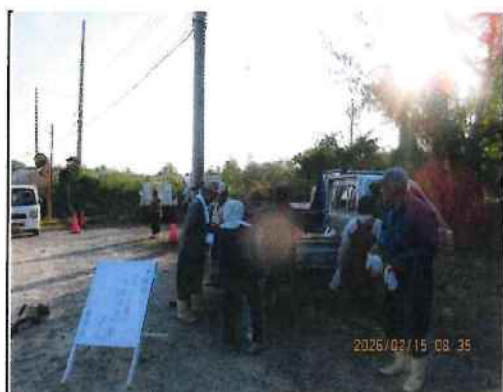
作業前打ち合わせ中
