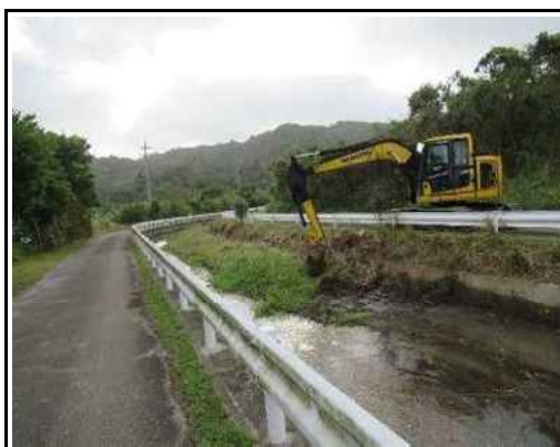
（排水路土砂撤去）
