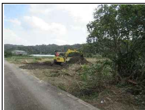
（排水路土砂撤去）
