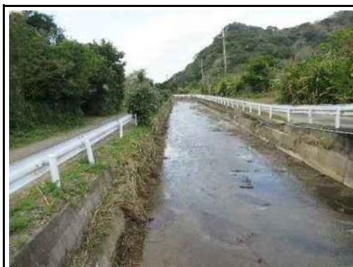
（排水路土砂撤去完了）
