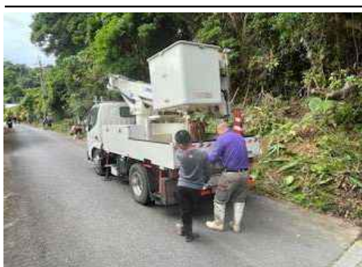
(高所作業車のセッティング)
