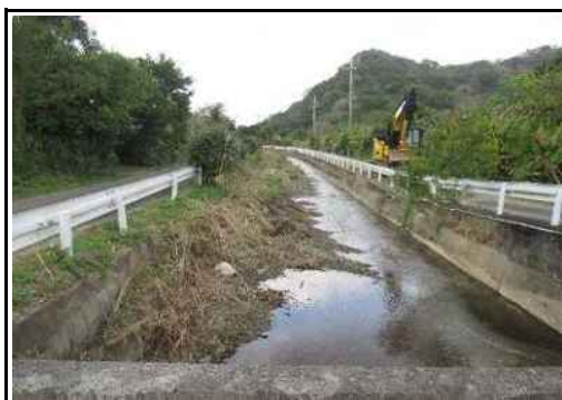
(排水路土砂撤去前)
