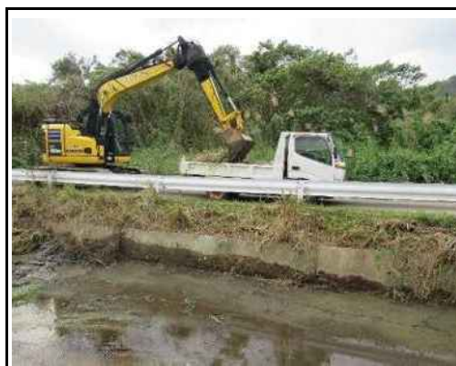
（排水路土砂撤去）
