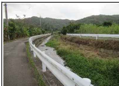
(排水路土砂撤去前)
