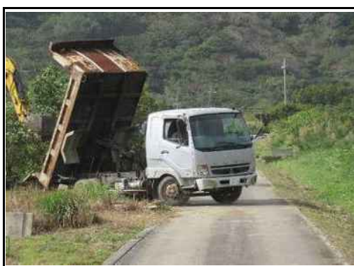
（排水路土砂撤去）
