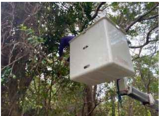
(高所作業車で枝の伐採)
