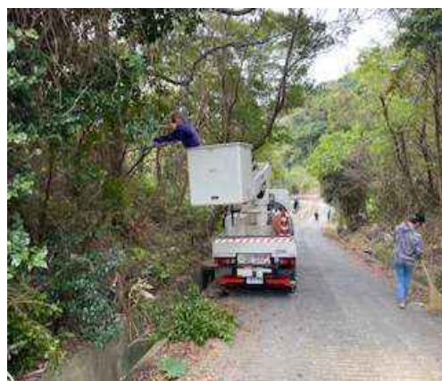
(高所作業車で枝の伐採)
