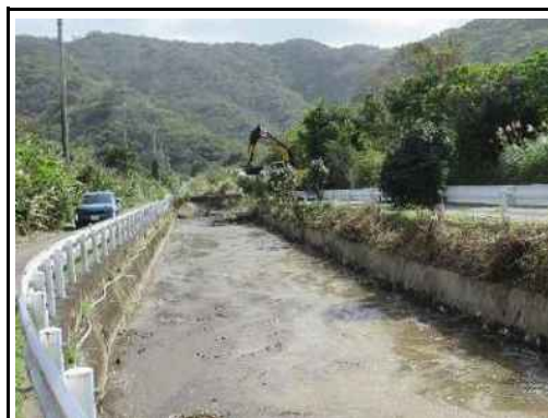
（排水路土砂撤去完了）
