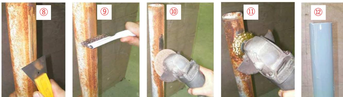
作業はサビの程度が小さい順に ⑧スクレーパー ⑨ワイヤーブラシを用いて除去します。サビが大きくて厚い場合はディスクグラインダーに ⑩ペーパーディスクや ⑪カップブラシを装着し除去します。サビをきれいに取り除いた後は ⑫さび止め塗料を塗布します。
