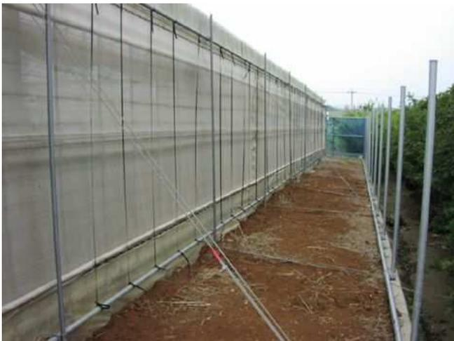
ワイヤーによる引張補強(宮古島市)
