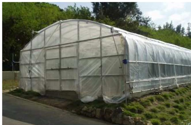
低コスト耐候性ハウスは最大瞬間風速50m/sの風荷重に耐えるように設計されている。
