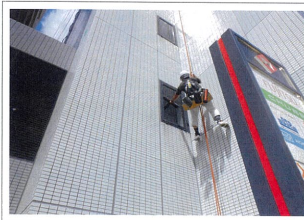
高所作業(窓ガラス清掃)
