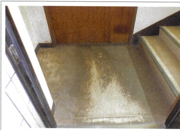
床面ワックス剥離前
