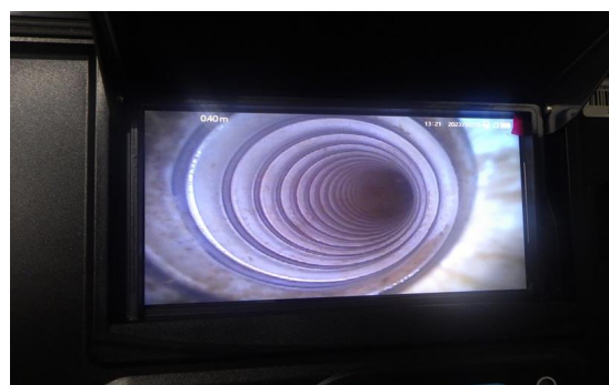
■画像の説明:カメラで排水管内部を撮影
