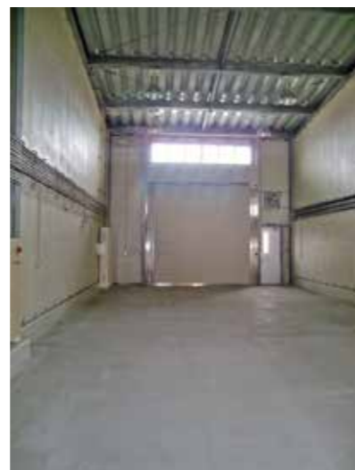
素形材産業振興施設内部 ※写真は2号棟のものです
