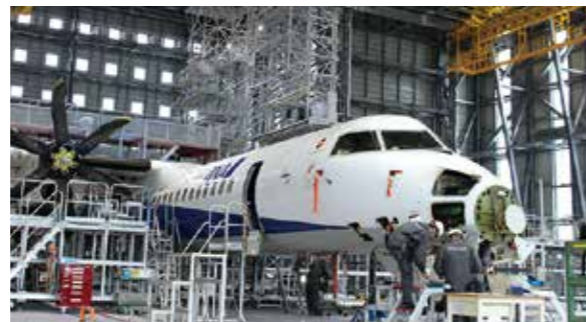
機体整備の様子 (航空機整備施設内大型ドック MROJapan株式会社)
