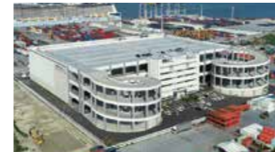
那覇港総合物流センター
