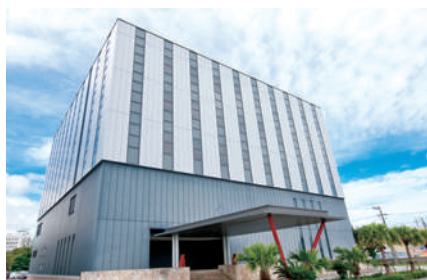
FRT数据中心
