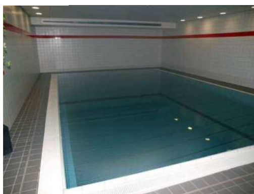
水深調整プール
