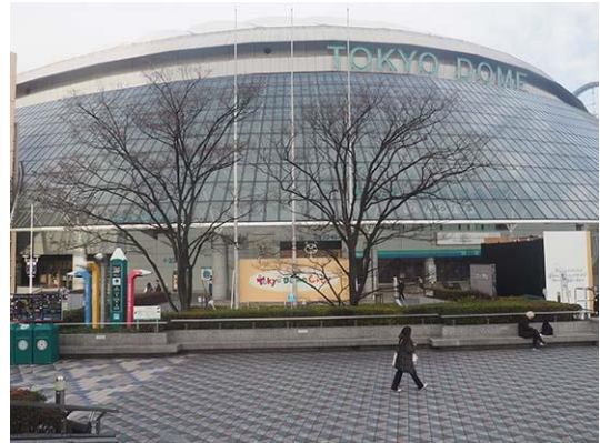
東京ドーム外観
