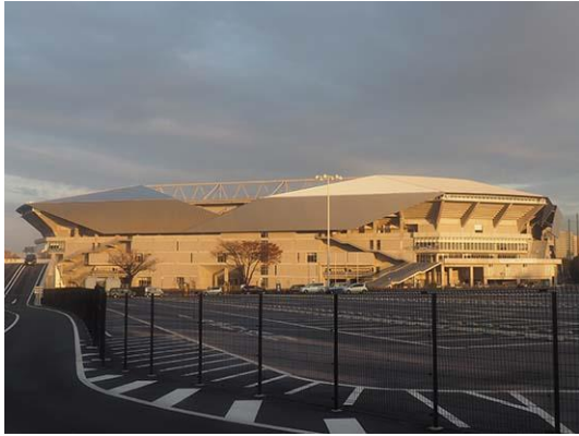
吹田スタジアム全景
