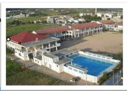
とても広い敷地
