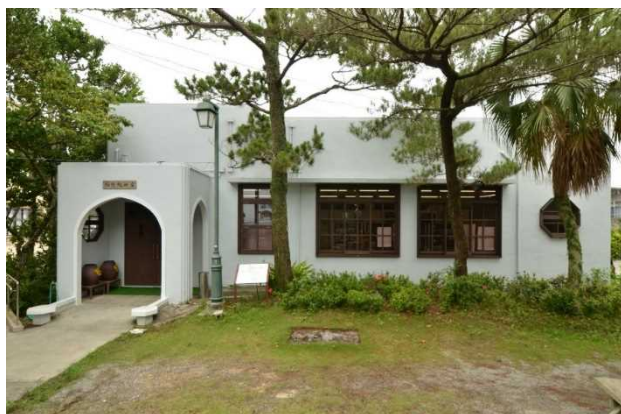
建物正面（南）外観
