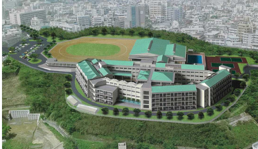
陽明高校改築工事
