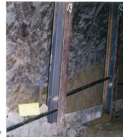
写真 II-1-3 上位：泥岩 下位：砂岩の境界
