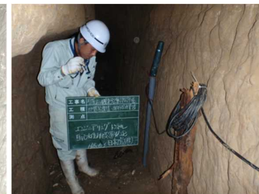
写真 I-2-74 水位観測用の自記水位計
