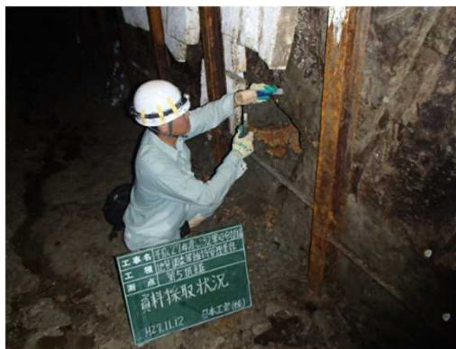
写真 I-2-68 泥岩のブロックサンプリングの様子
