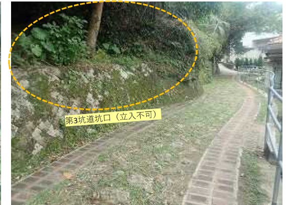
写真 I -2-41 第3坑道坑口周辺部
