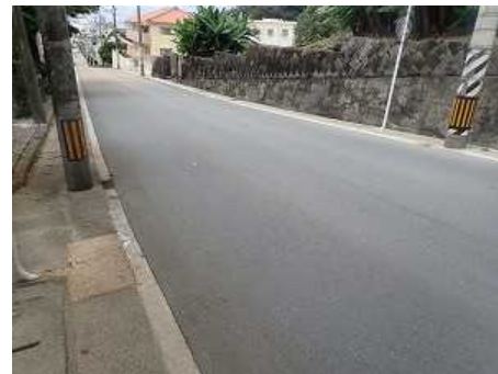
写真 I-2-60 舗装部（変状なし）
