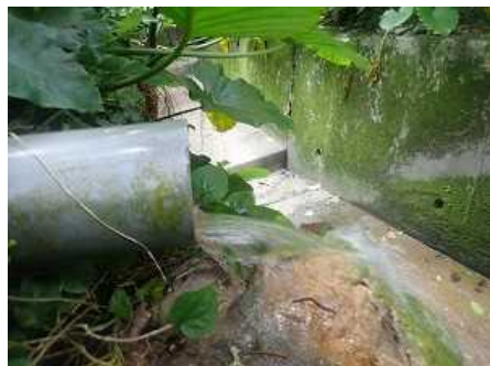
写真 I -2-47 第5坑道からの湧水（常時10～30L/分）
