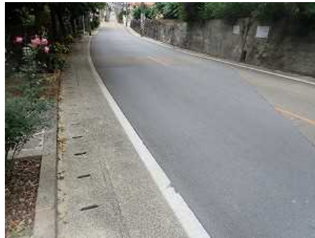
写真 I-2-58 舗装部（変状なし）
