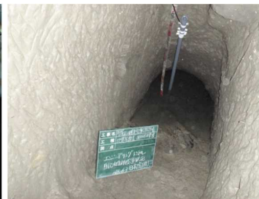
写真 I-2-73 エンジニアリングトンネル内水位観測の様子
