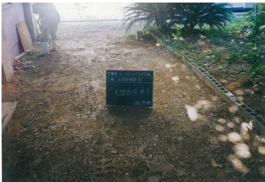
写真 I-2-23 完了（平成14年1月24日）
