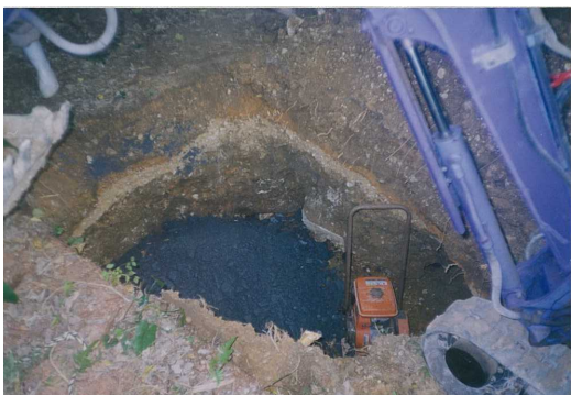
写真 I-2-21 礫質土による埋戻し
