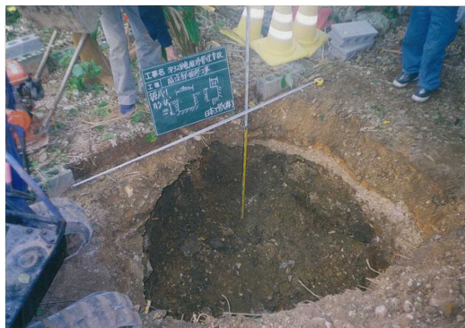
写真 I-2-20 掘削状況（補修対策）
