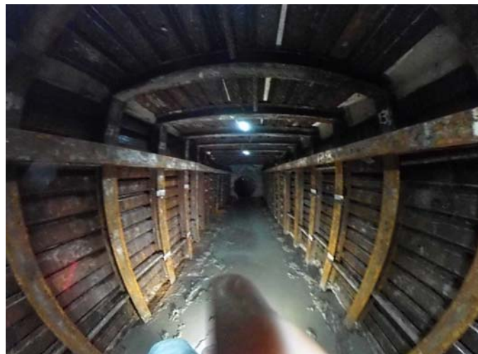
調査時の第5坑道の状況②(令和3年8月)
