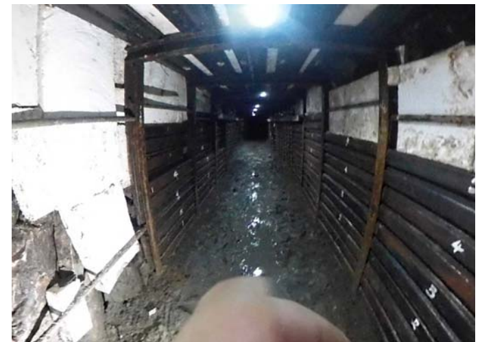
調査時の第5坑道の状況(令和3年8月18)
